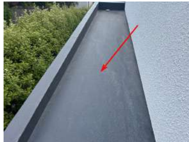
Butynol membrane roof
