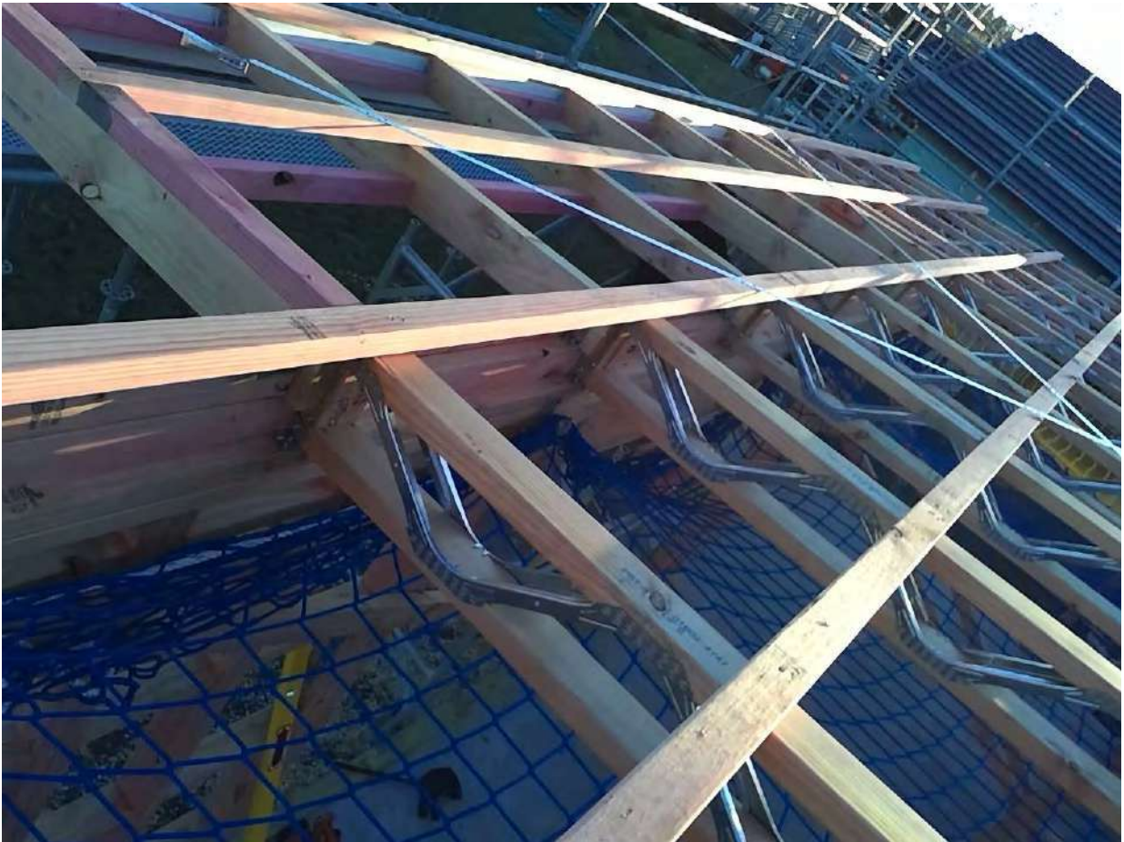
pozi strut fixings
