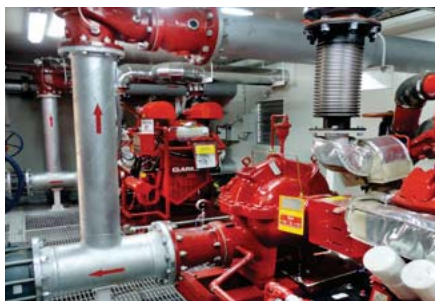
Skids de bombeo, con caseta y piping fabricados bajo norma NFPA-20, con motores eléctrico y diesel, estanques, instrumentación y bombas Peerless certificadas UL/FM.
