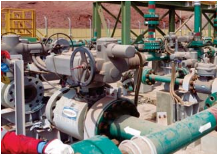
Conjunto válvula de bola ValvTechnologies para servicios severos y actuador inteligente Auma para líneas de concentrado.
