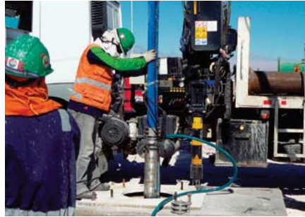
Conjunto bomba de pozo profundo Grundfos con motor integrado, cable, tubería flexible y terminales Tipsa.
