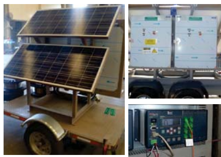
Sistema de medición de presión y temperatura en pilas de lixiviación con sensores de fibra óptica Opsens.
