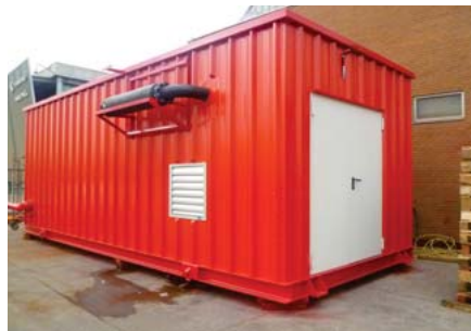
Skids de bombeo, con caseta y piping fabricados bajo norma NFPA-20, con motores eléctrico y diesel, estanques, instrumentación y bombas Peerless certificadas UL/FM.
