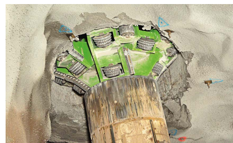
Perforación de la cabeza escariadora.
