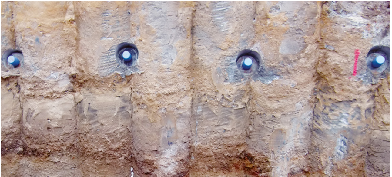
Abdichtung einer Bohrfahllwand
