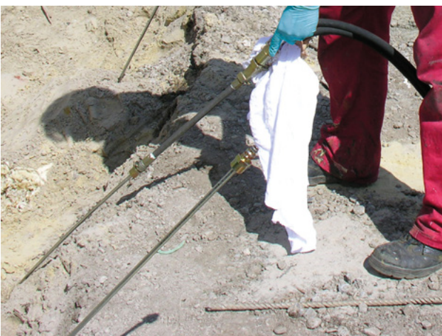
Untergrundstabilisierung
