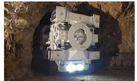
Pozos de perforación verticales e inclinados en espacios reducidos.
