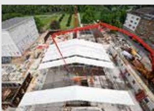
Andamios de protección
