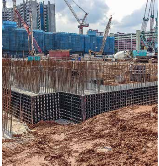
Los paneles DUO eran ideales para el encofrado de componentes de hormigón de pequeño formato con bajos requisitos de superficie.
