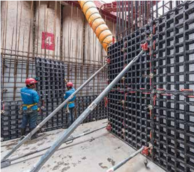
Paneles de encofrado de bajo peso y pequeño tamaño: DUO aprovecha plenamente estas ventajas en estos muros de sótano.
