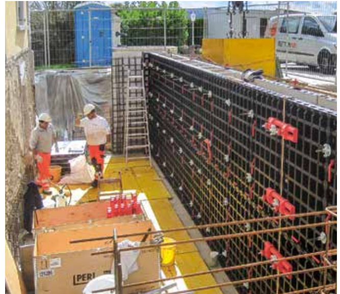
Modificación y ampliación sin usar una grúa: se soluciona mejor con DUO.
