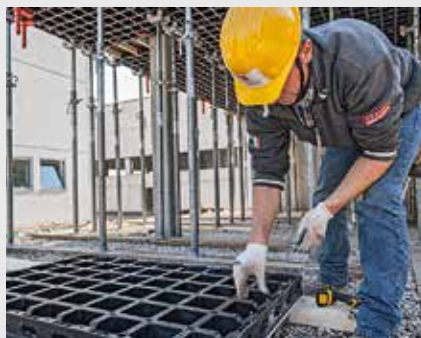
4. Atornillar la nueva superficie encofrante
