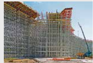
Cimbras y torres de carga
