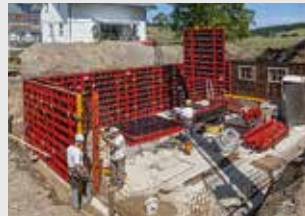
Encofrados para muros
