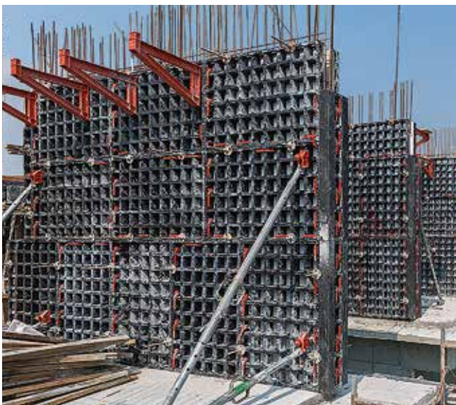
Primer uso con éxito del encofrado universal ligero para la fabricación de pilares apantallados.
