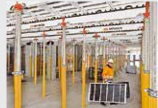
Encofrados para losas
