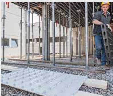
3. Preparar la nueva superficie encofrante
