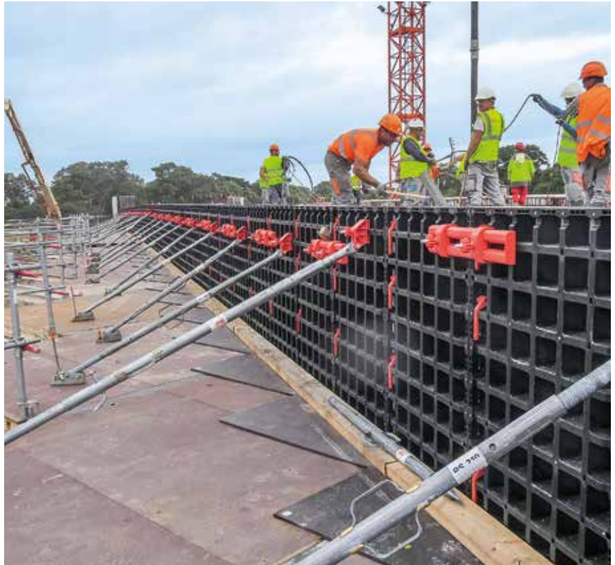
DUO es ideal para cimientos de encofrado debido a sus tamaños de panel pequeños y manejo simple.
