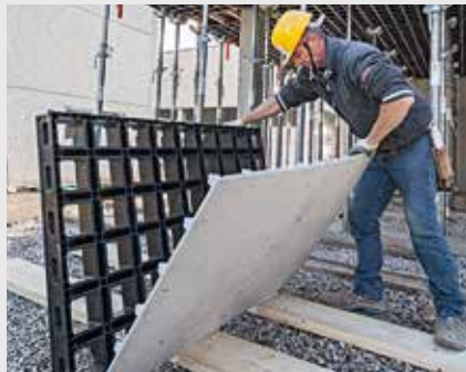
2. Retirar la superficie encofrante dañada
