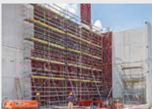
Andamios de trabajo para la construcción
