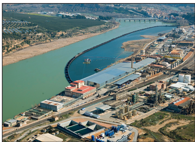
Figura 5. Fotografía general y detalle embalse de Flix. Cabe destacar la barrera que impide la propagación de los residuos químicos.
