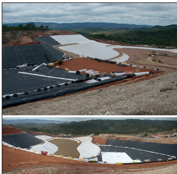
Figura 10. Vistas aéreas del Flix en fase constructiva.
