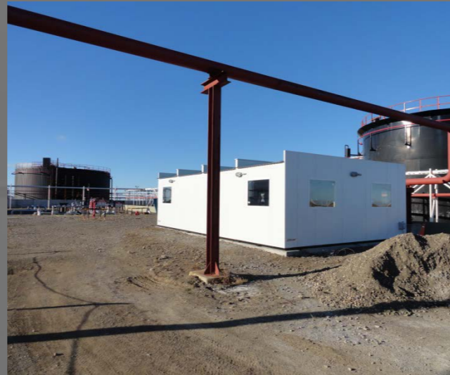
Salas de máquinas
