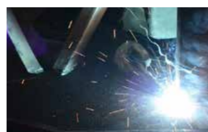
SOLDADURA DE HIERRO
