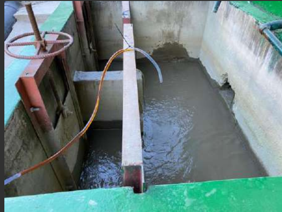
Dosificación del PT-MET 50 junto con el floculante aniónico PT-Floc 1070.
