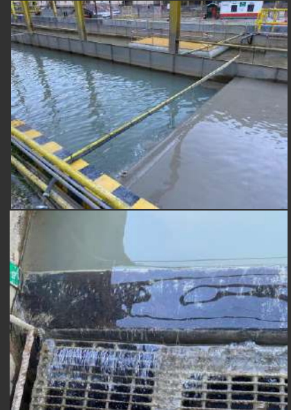
Luego del acondicionamiento se nota el cambio de coloración, turbidez y lo más importante bajos niveles de metales disueltos (Cu, Pb, Zn, Mg y Mn)
