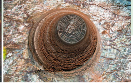
Lanzamiento exitoso: más de 60 chimeneas han sido excavadas hasta ahora con una longitud promedio de 16,5 m y una tasa de avance promedio de 1,5 m/h.
