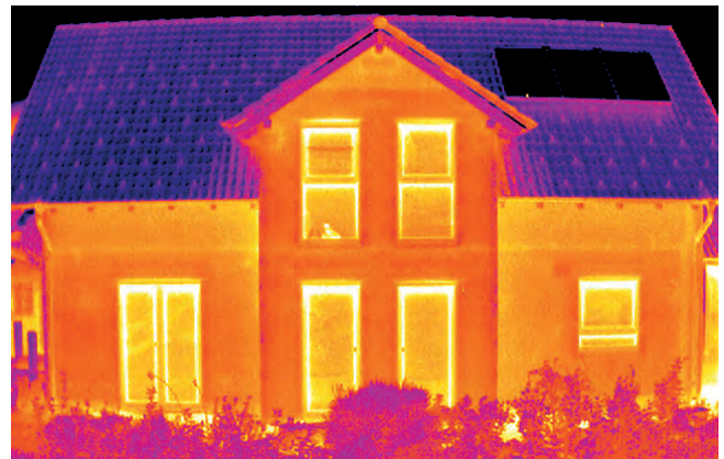
Compleja fachada de un edificio en una toma panorámica.
