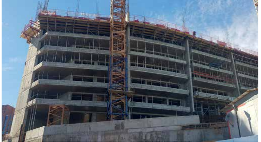
Edificio residencial Punta Pacífico (Viña del Mar, Chile)
