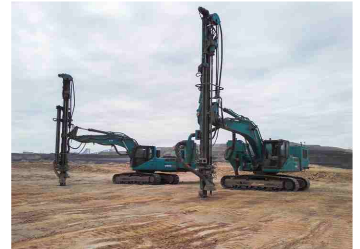
新疆施工 xinjiang construction
