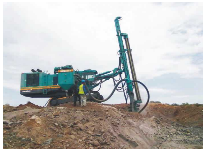
纳米比亚施工 Construction in Namibia
