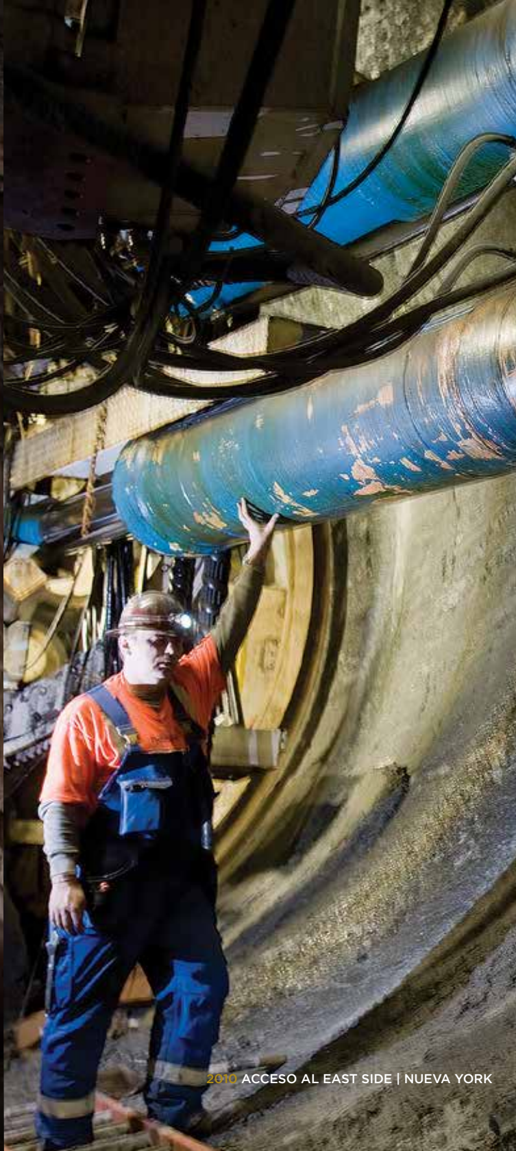
2011 PROYECTO DE TÚNEL DEL NIÁGARA | CANADÁ
