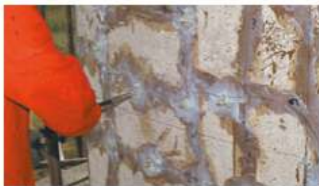
Injection of PU resins
