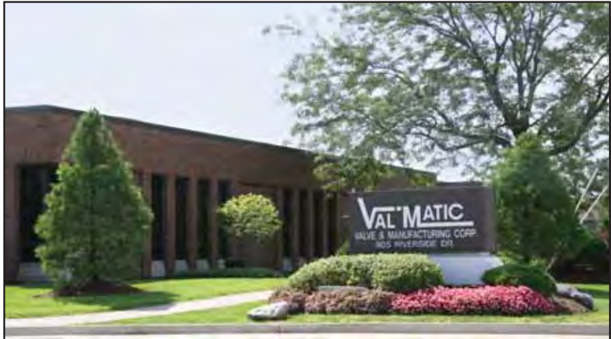
Elmhurst, IL Facility
