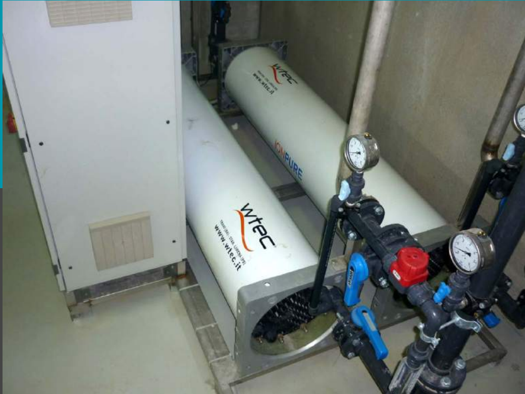
Plantas EDI Refinación de agua desmineralizada agua de alimentación para la turbina de vapor
