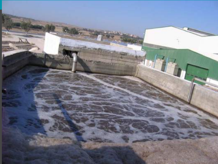
Planta Químico / físico - biológico Caudal de 360 mc/día por aguas residuales de las refinерías de aceite vegetal
