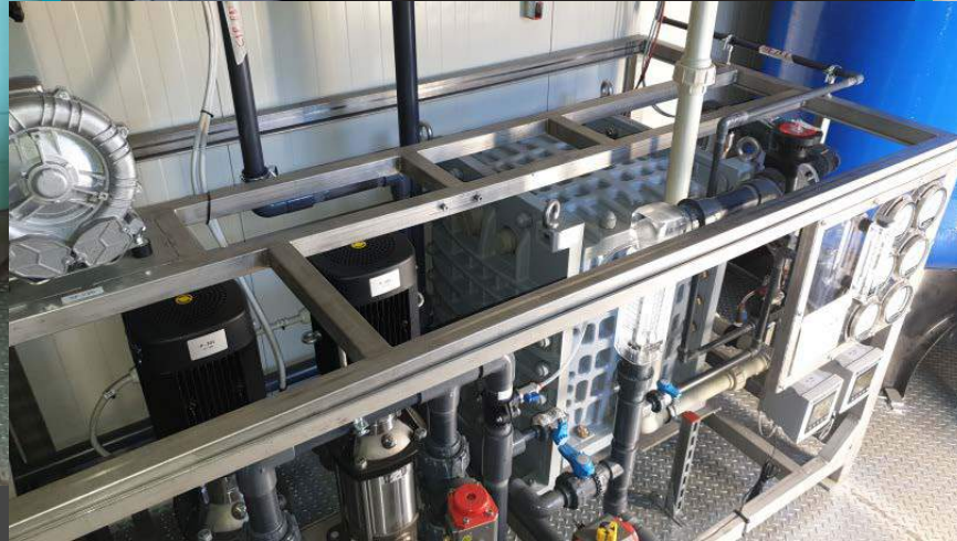
Planta de ósmosis inversa + EDI: caudal de 200 mc/día producción de agua demi a <0,2 \mu\text{S/cm}
