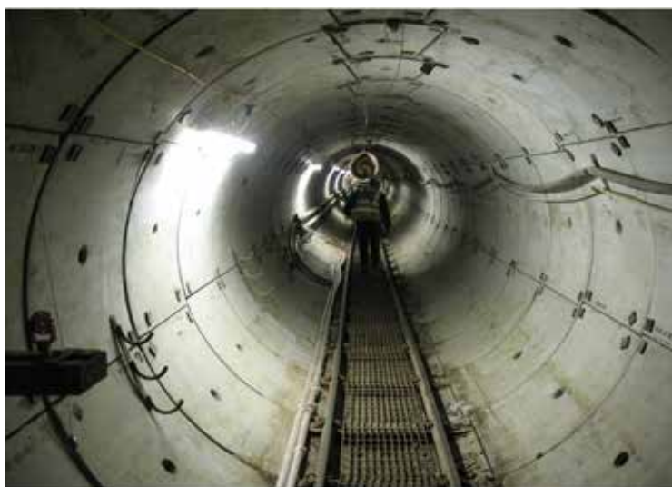
Imagen 4: Un revestimiento de túnel segmentado está diseñado para estar en compresión, lo que significa que la fluencia por tracción aislada de refuerzo de fibra no es un factor.
