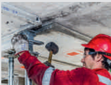
En los paneles para losa interiores los cabezales de caída se descenden con un golpe de martillo ...
