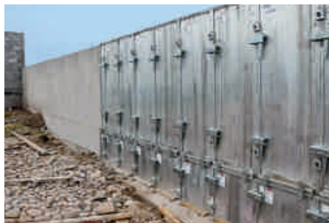
Proyecto de viviendas Mazatlán, México Muro perimetral del barrio de viviendas Muros de hormigón armado de 2,40 m de altura Ejecución con puestas de hormigonado de 12 m de largo
