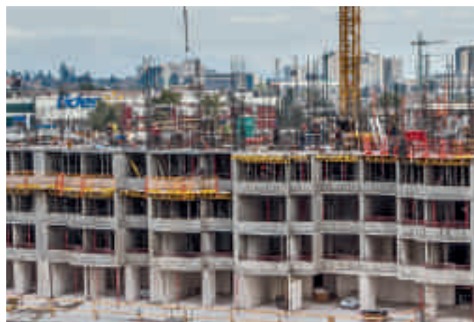
Edificio Las Palmas Proyecto de viviendas en Santiago, Chile Edificio de 25 pisos Más de 2.500 m 2 de superficie de muros y losas por piso
