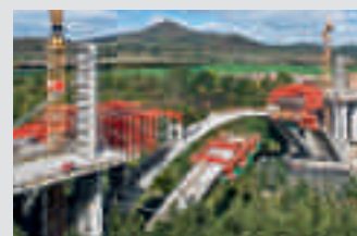
Encofrados para puentes
