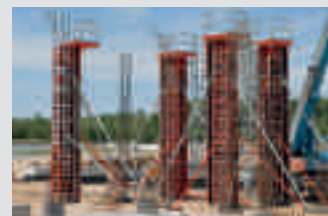
Encofrados para pilares y columnas circulares
