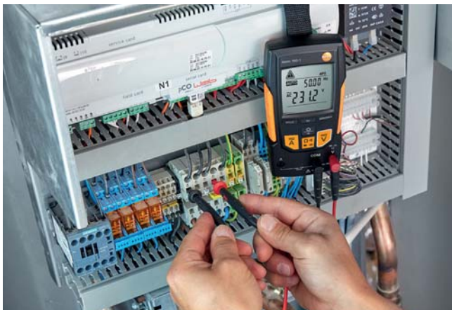
Medición de tensión en el panel de conexiones de una bomba de calor.
