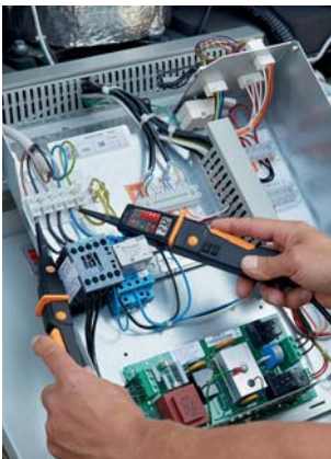
Medición de tensión en un comproresor.
