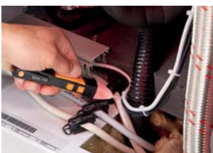
Primera comprobación de la alimentación de tensión en un compresor.
