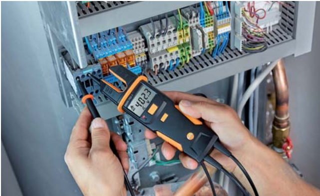
Comprobación de tensión en una bomba de calor con testo 755 .
