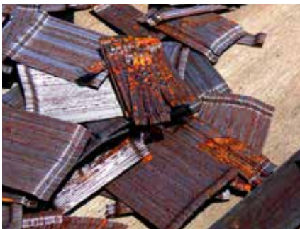
Corrosión de las fibras de Acero
