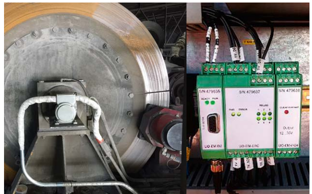
Después: Unidad U-ONE básica con módulos electrónicos montada directamente en el armario de distribución / After: Direct mounted U-ONE basic unit with electronic modules in the switchboard
