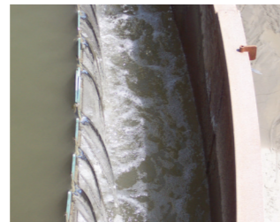
Agua limpia producida desde el caudal inferior procesado a través del espesador de McLanahan.
