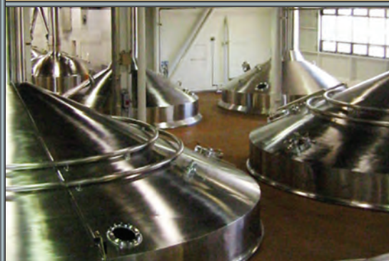
El sistema de supresión de incendios con CO 2 es efectivo en diversos procesos industriales.
