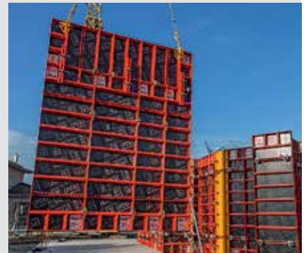
Las uniones en altura se pueden hacer con paneles LIWA en sentido horizontal hasta una altura de 3,85 m. La correa de compensación transmite los esfuerzos y rigidiza.
