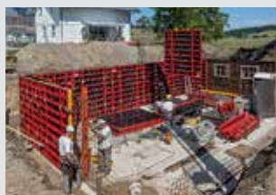
Encofrados para muros
