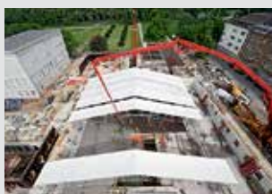
Andamios de protección
