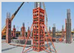
Encofrados para pilares y columnas circulares
