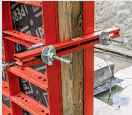
El sencillo tape lateral con madera escuadrada y tablero de compensación.
