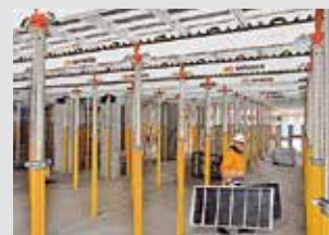
Encofrados para losas
