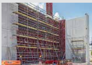
Andamios de trabajo para la construcción
