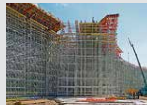
Cimbras y torres de carga
