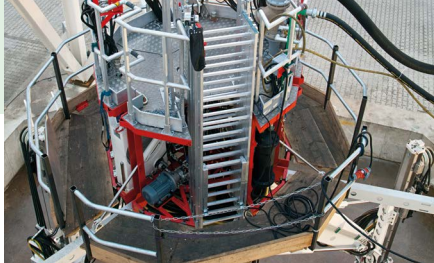
Plataforma de control con escalera de acceso.
