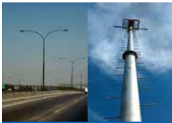
POSTE CARRETERA TORRE DE ILUMINACIÓN
