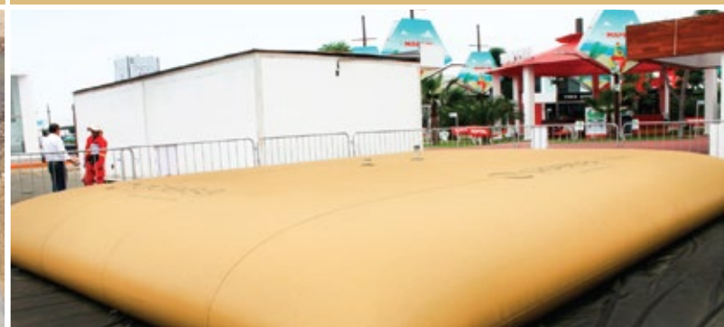
■ Estacionario 50 000 Lts. BOULEVARD DE ASIA Agua potable
