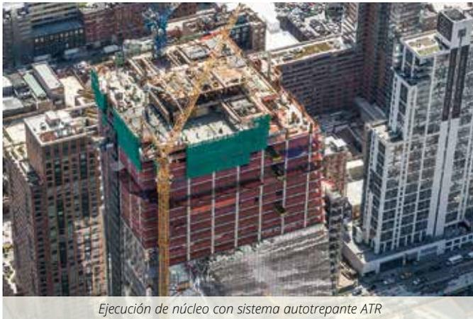
Ejecución de núcleo con sistema autotrepante ATR
