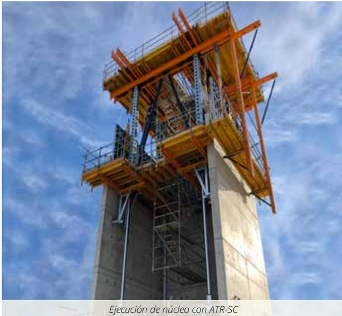
La **elevación del sistema** se realiza de manera **continua** mediante una única extensión del cilindro, sin necesidad de ningún tipo de carril, simplemente **apoyándose y guiándose sobre los muros ejecutados anteriormente**.
