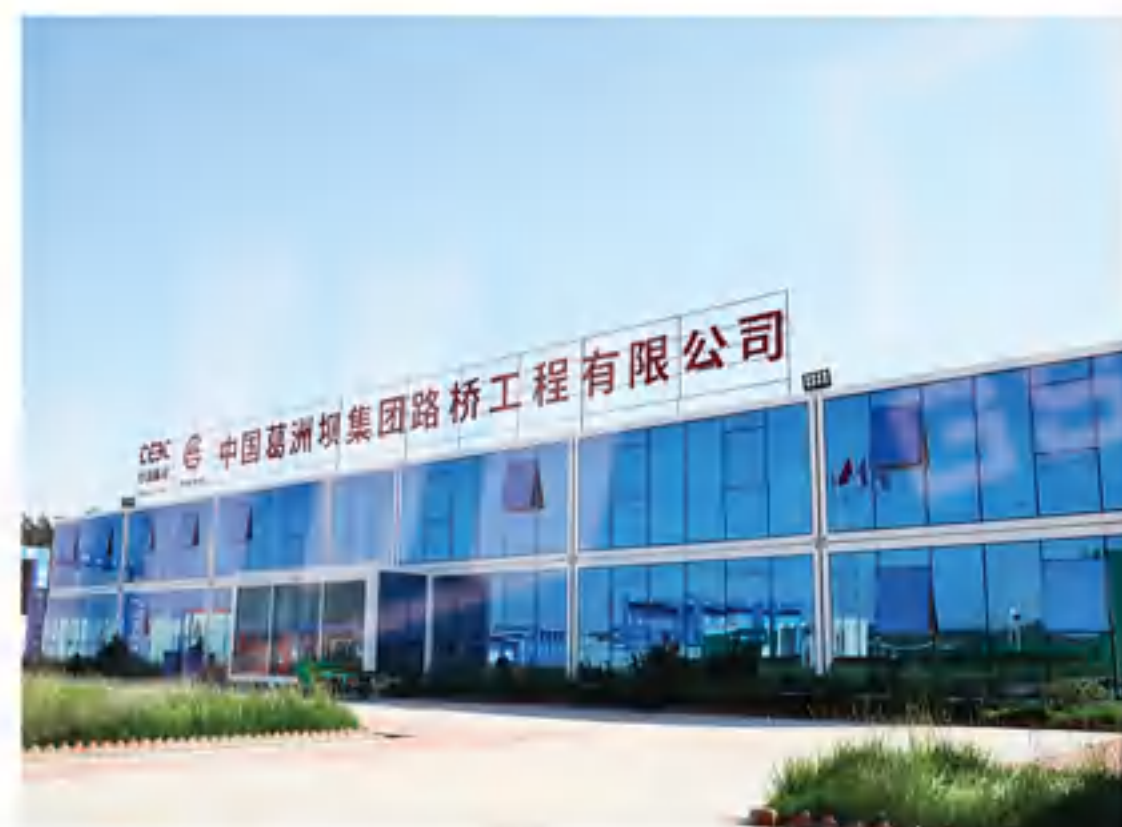
葛洲坝集团雄安容城截洪渠二期工程项目 CEECC Xiong'an Rongcheng Flood Interception Canal Phase II Project
