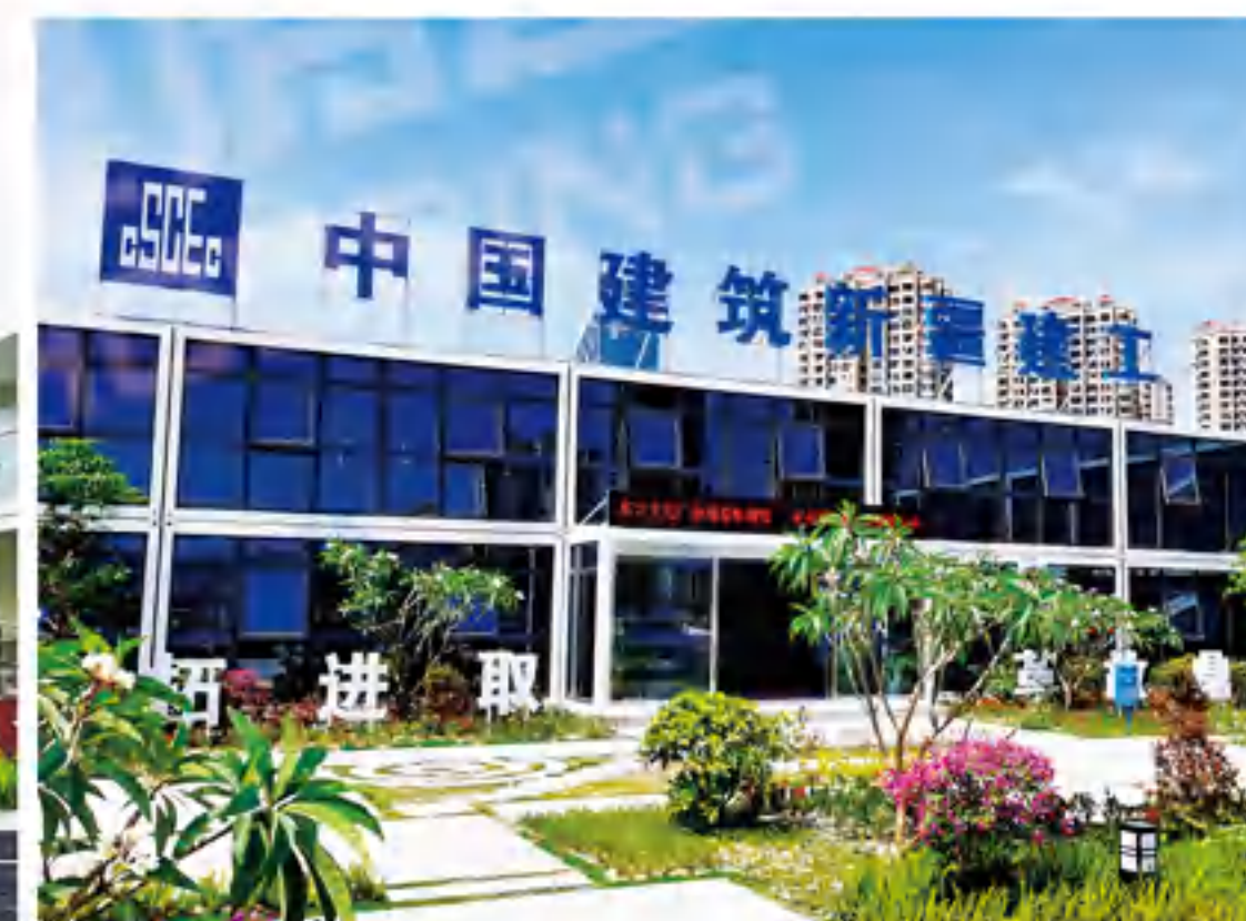
中建新疆建工海南东方文化广场项目 CSCEC Xinjiang Construction Engineering Hainan Oriental Culture Plaza Project
