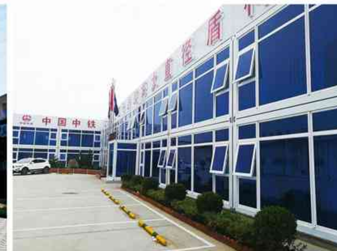
中铁一局大连地铁5号线项目 REC First Bureau Dalian Metro Line 5 Project
