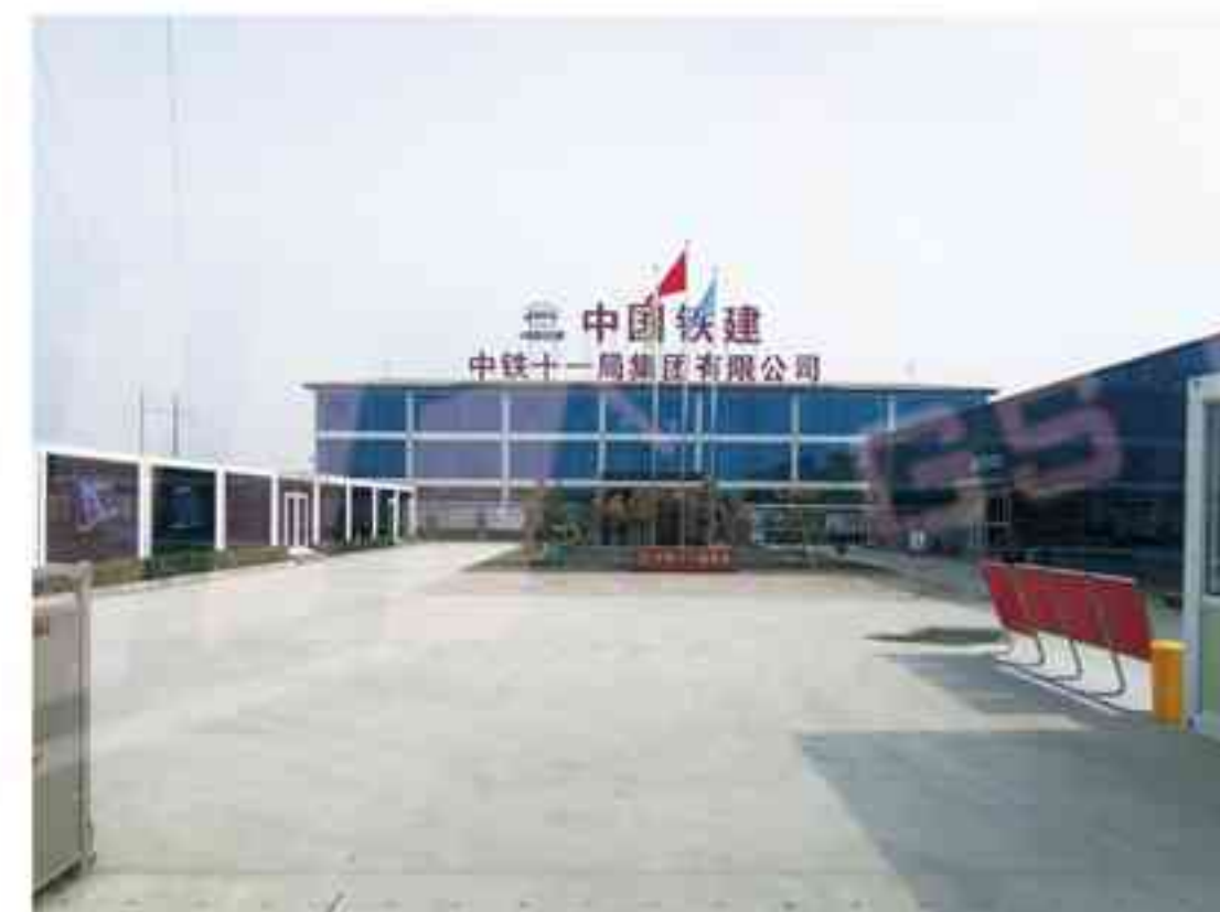
中铁建十一局容西市政管廊项目 CRCC 11th Bureau Rongxi Municipal Pipe Gallery Project
