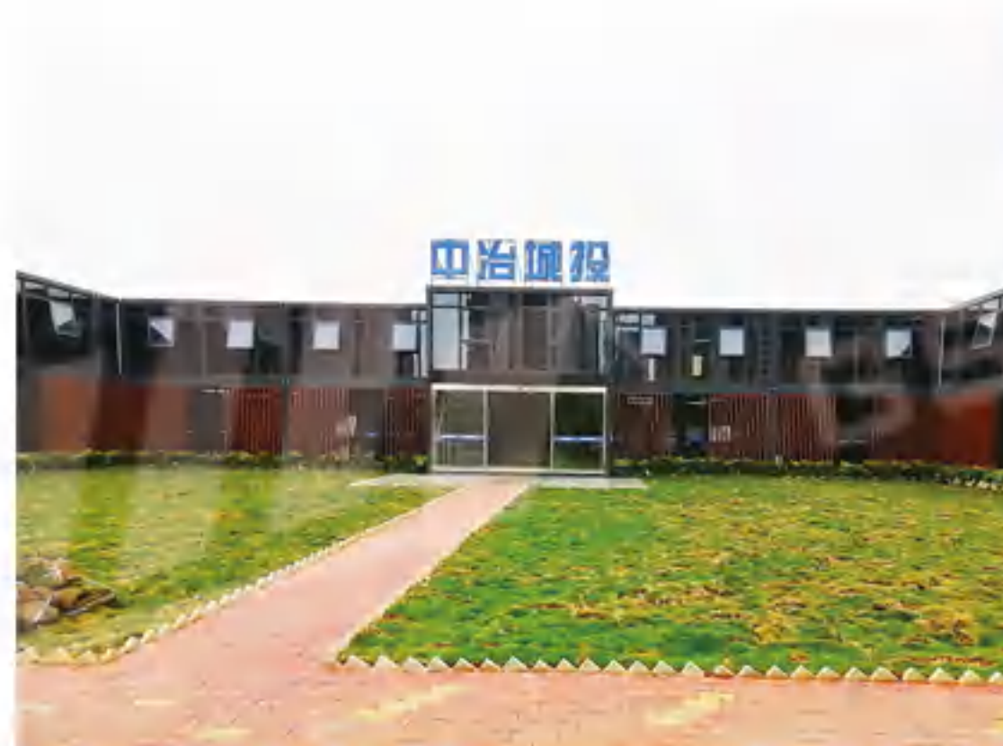
中冶城投珠海金湾艺术中心项目 MCC Zhuhai Jinwan Art Center Project
