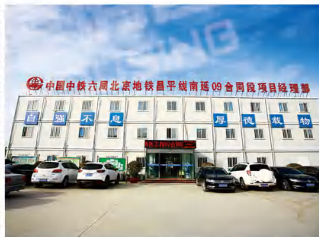
中铁六局北京地铁昌平线南延项目 REC 6th Bureau Beijing Metro Changping Line South Extension Project
