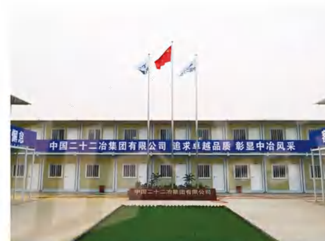
中国二十二冶石家庄钢厂项目 MCC Shijiazhuang Steel Plant Project
