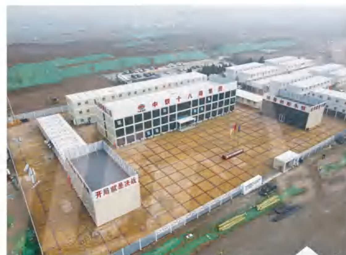
中铁建十八局雄安容西片区市政管廊二标项目 CRCC 18th Bureau Xiong'an Rongxi Municipal Pipe Gallery Project
