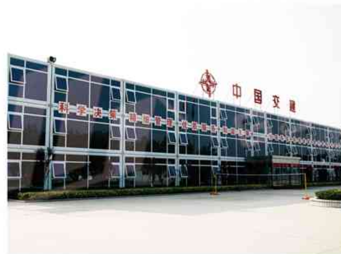
中交天津宝坻“地下管廊”项目 CCCC Tianjin Baodi "Underground Pipe Gallery" Project
