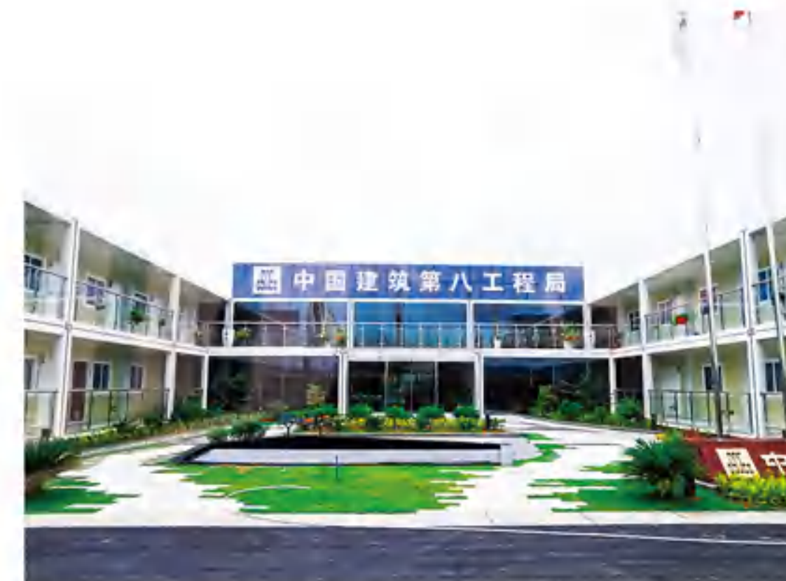
中建八局广州国际生物医院创新中心项目 CSCEC 8th Bureau Guangzhou International Biological Hospital Innovation Center Project
