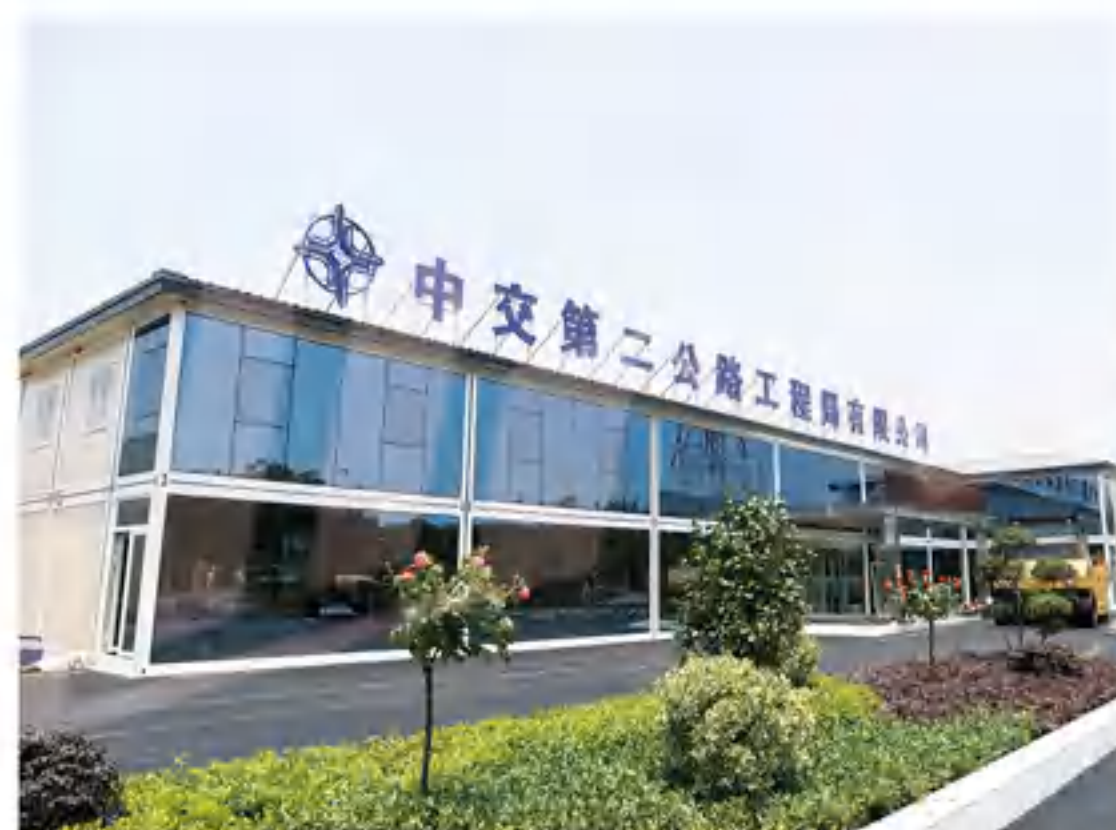
中交二公局南京龙潭长江大桥项目 CCCC Nanjing Longtan Yangtze River Bridge Project
