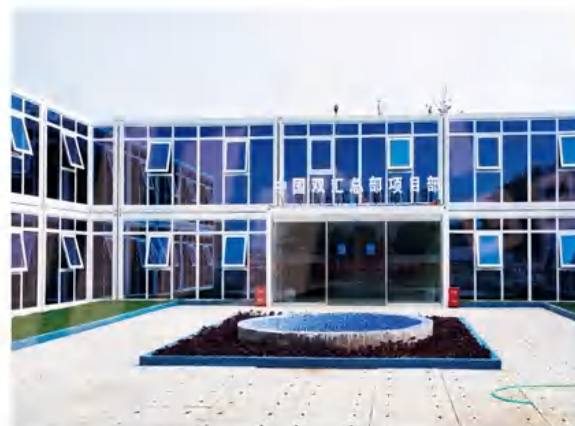
中建七局河南中国双汇总部项目 CSCEC 7th Bureau Henan Shuanghui Headquarters Project
