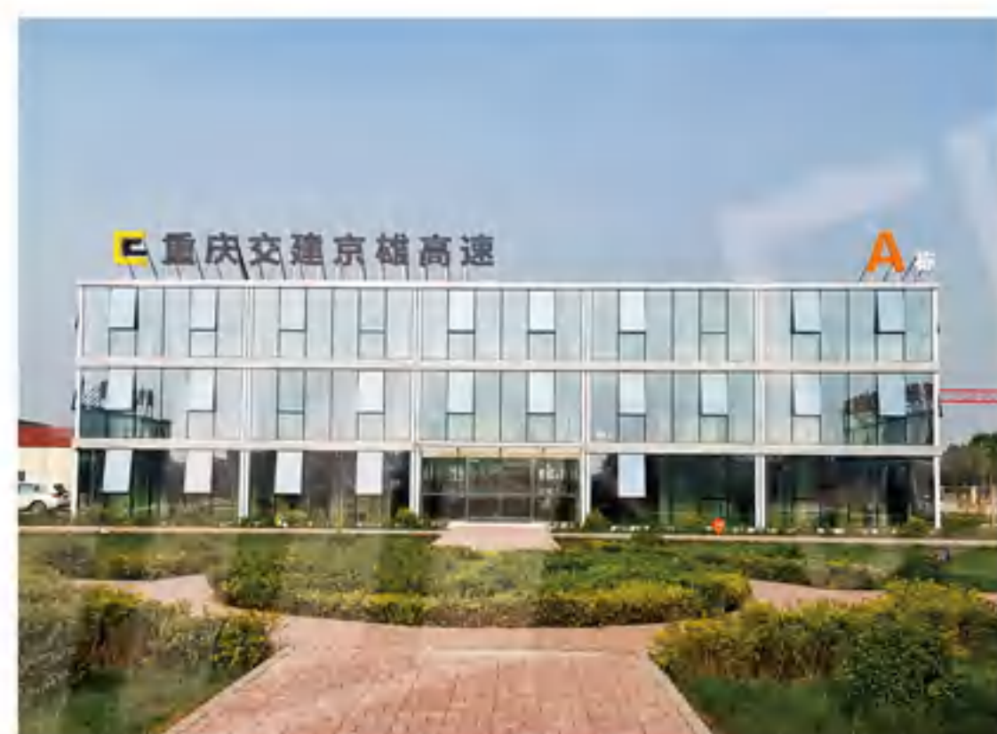
重庆交建京雄高速路SG2项目 CQCC Jingxiong Expressway SG2 Project
