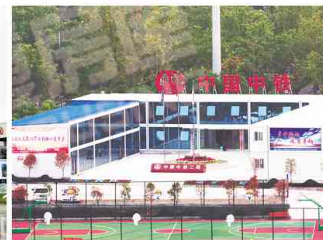
中铁二局重庆地铁4号线项目 REC Second Bureau Chongqing Metro Line 4 Project
