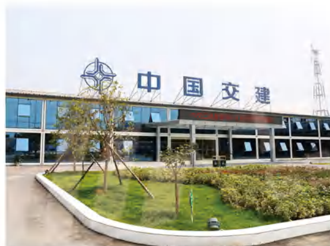
中交二航局南京龙潭长江大桥项目 CCCC Nanjing Longtan Yangtze River Bridge Project
