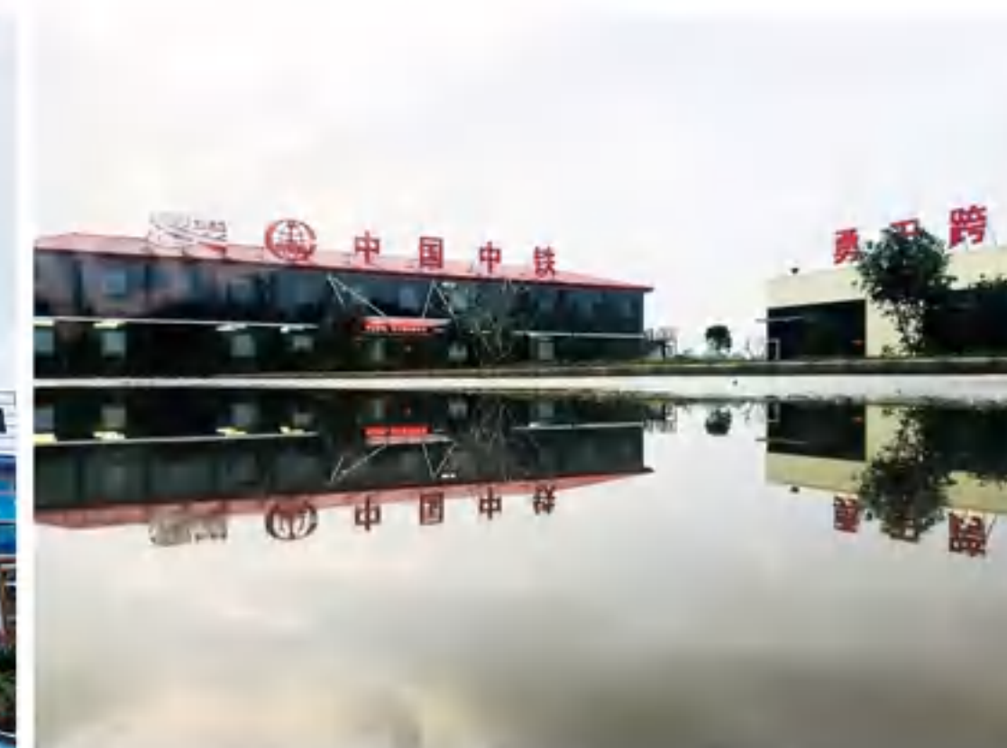
中铁大桥局季华路西延线项目 REC Bridge Bureau Jihua Road West Extension Project
