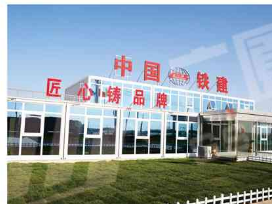
中铁建十二局雄安新区容东项目 CRCC 12th Bureau Xiongan New District Rongdong Project
