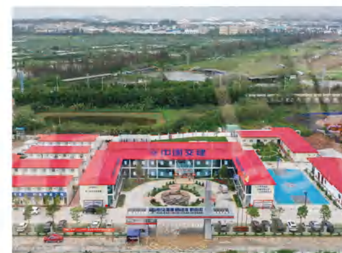
中交路桥富龙西江特大桥项目 CCCC Road Bridge Fulong Xijiang Bridge Project
