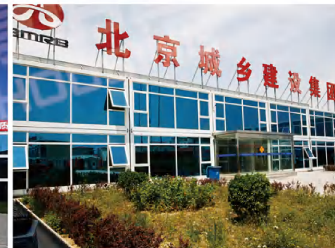
北京城乡集团大兴机场项目 Beijing Urban and Rural Group Daxing Airport Project
