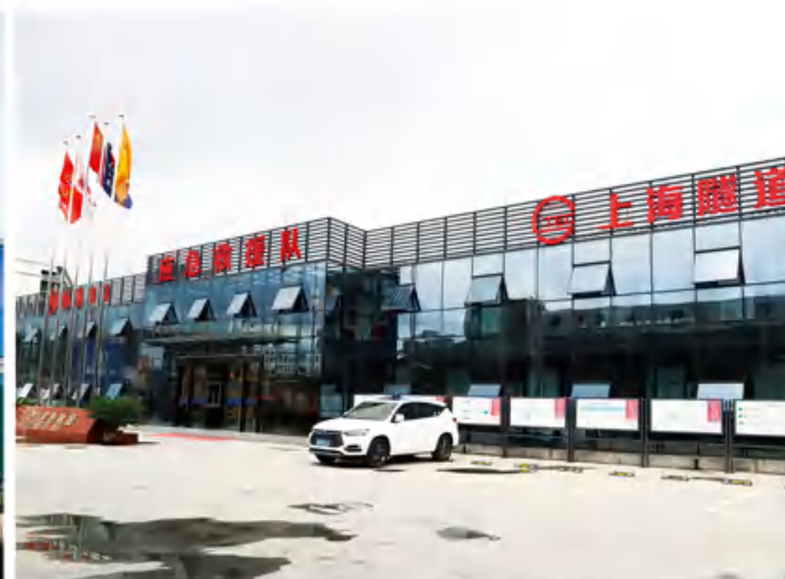
上海隧道杭州地铁应急救援队项目 TEC Hangzhou Metro Emergency Rescue Team Project
