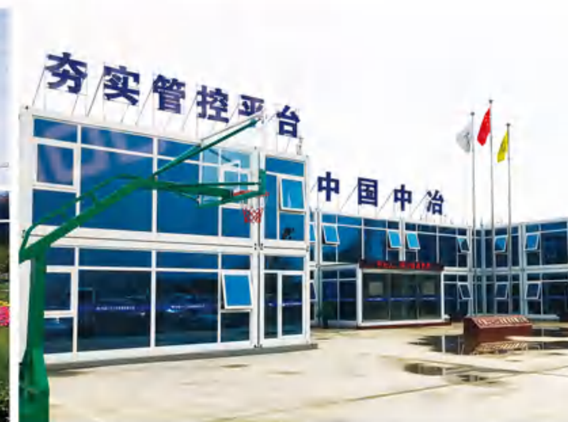
中国二十二冶沈阳恒大项目 MCC Shenyang Evergrande Project
