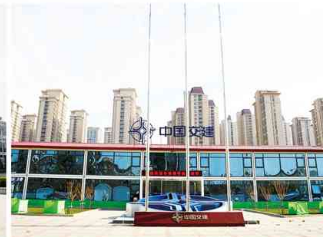
中交一航局天津地铁11号线项目 CCCC Tianjin Metro Line 11 Project
