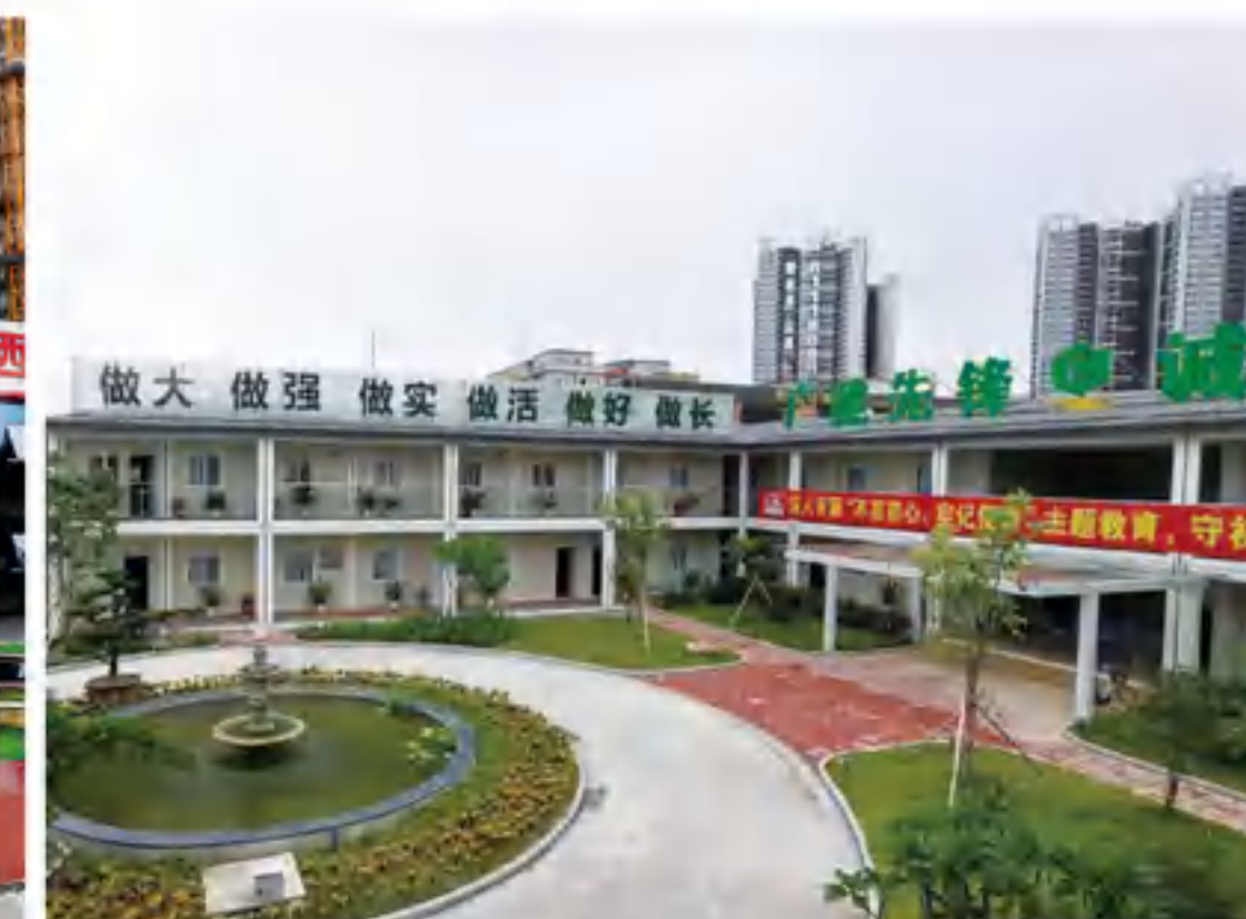
广东华隧广州地铁14号线项目 CTC Guangzhou Metro Line 14 Project
