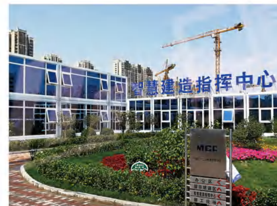
中国二十二冶唐山浭阳新城项目 MCC Tangshan Xinyang New City Project
