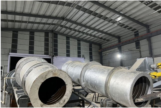
Tanque de temple
