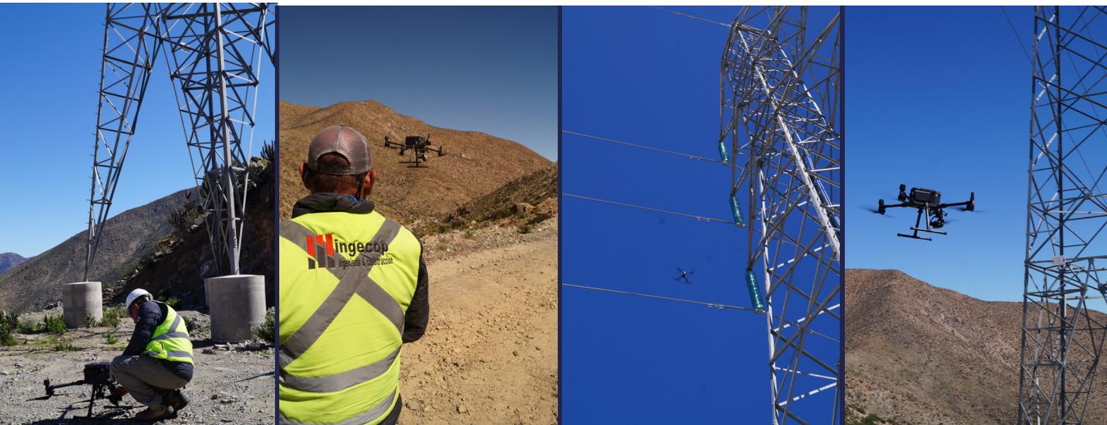
**Detección precisa de anomalías:** Los drones equipados con cámaras de alta resolución y termografía pueden identificar problemas en las torres y líneas eléctricas con gran precisión. Desde daños visibles hasta corrosión o desgaste, estos dispositivos detectan cualquier anomalía antes de que se convierta en un problema mayor.
