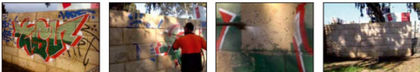
Arriba se puede ver la secuencia en donde solo con agua caliente, una presión de 2000 psi y un flujo de 10 litros por minuto se puede remover el graffiti en una pared que previamente había sido protegida con el protector. Abajo se utiliza la yuda de uno de nuestros productos.
