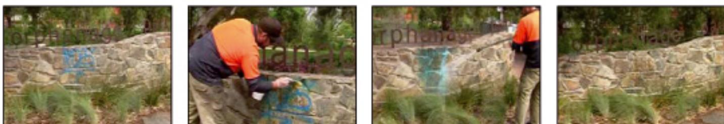
Se recomienda, dependiendo de lo severo del rayado volver a hacer una aplicación, solo en la zona vandalizada de este producto y así mantener la superficie totalmente protegida, incluso si la pared continúa húmeda.
