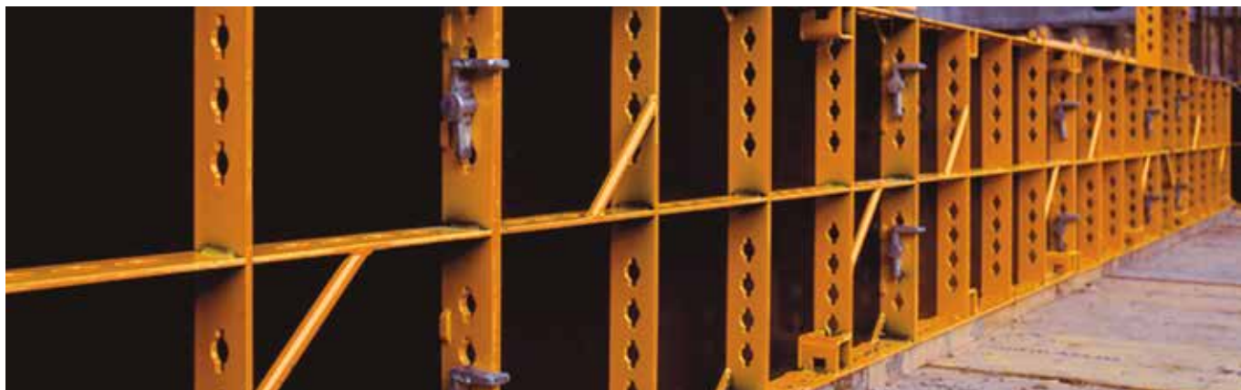
COMAIN como encofrado del lateral de la viga
