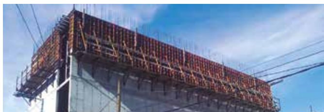
Encofrado trepante
