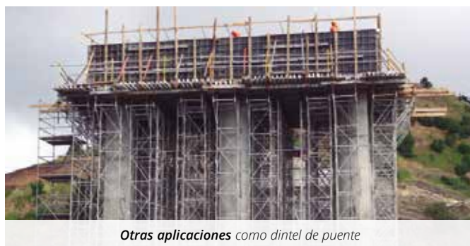
Grandes pilares con Andamio multidireccional BRIO como accesos y plataformas de trabajo
