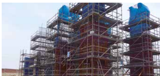
Grandes pilares con Andamio multidireccional BRIO como accesos y plataformas de trabajo
