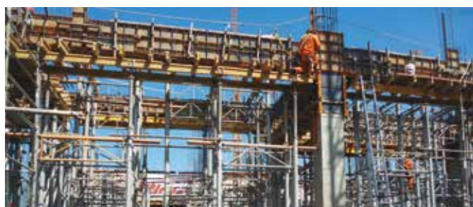
COMAIN sobre ENKOFLEX apoyado con torres ALUPROP
