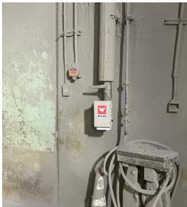
Monitoreo en línea de material particulado y sílice en planta de chancado IA + IoT
