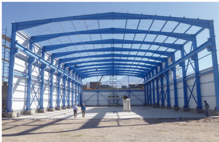
Edificios Industriales de gran eficiencia estructural
