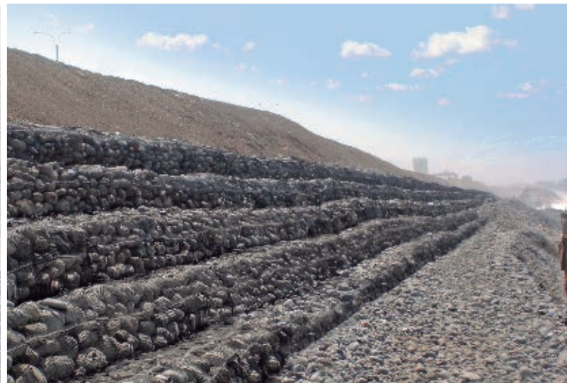
Gavión Grid como muro de contención.
