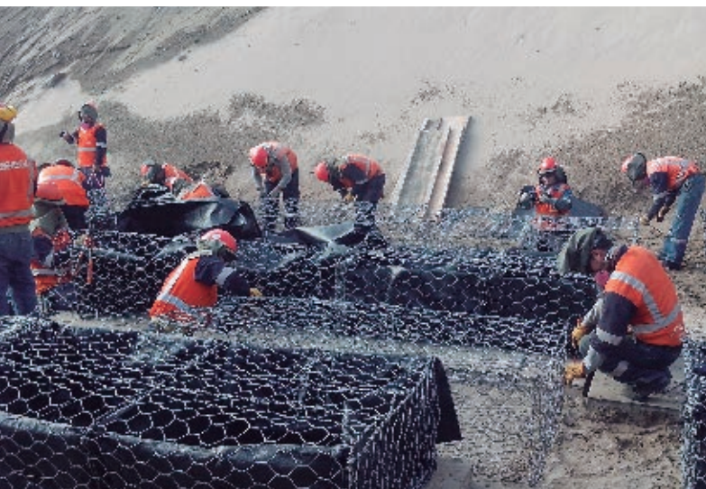
Armado del Gavión Tex.
