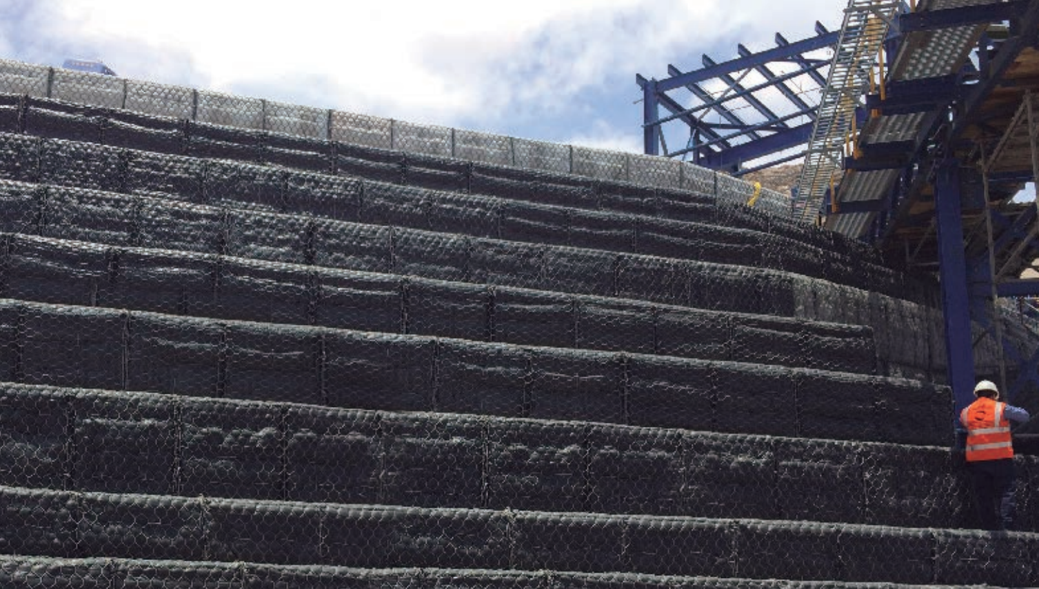
Sistema Gavión Tex como muro de contención.
