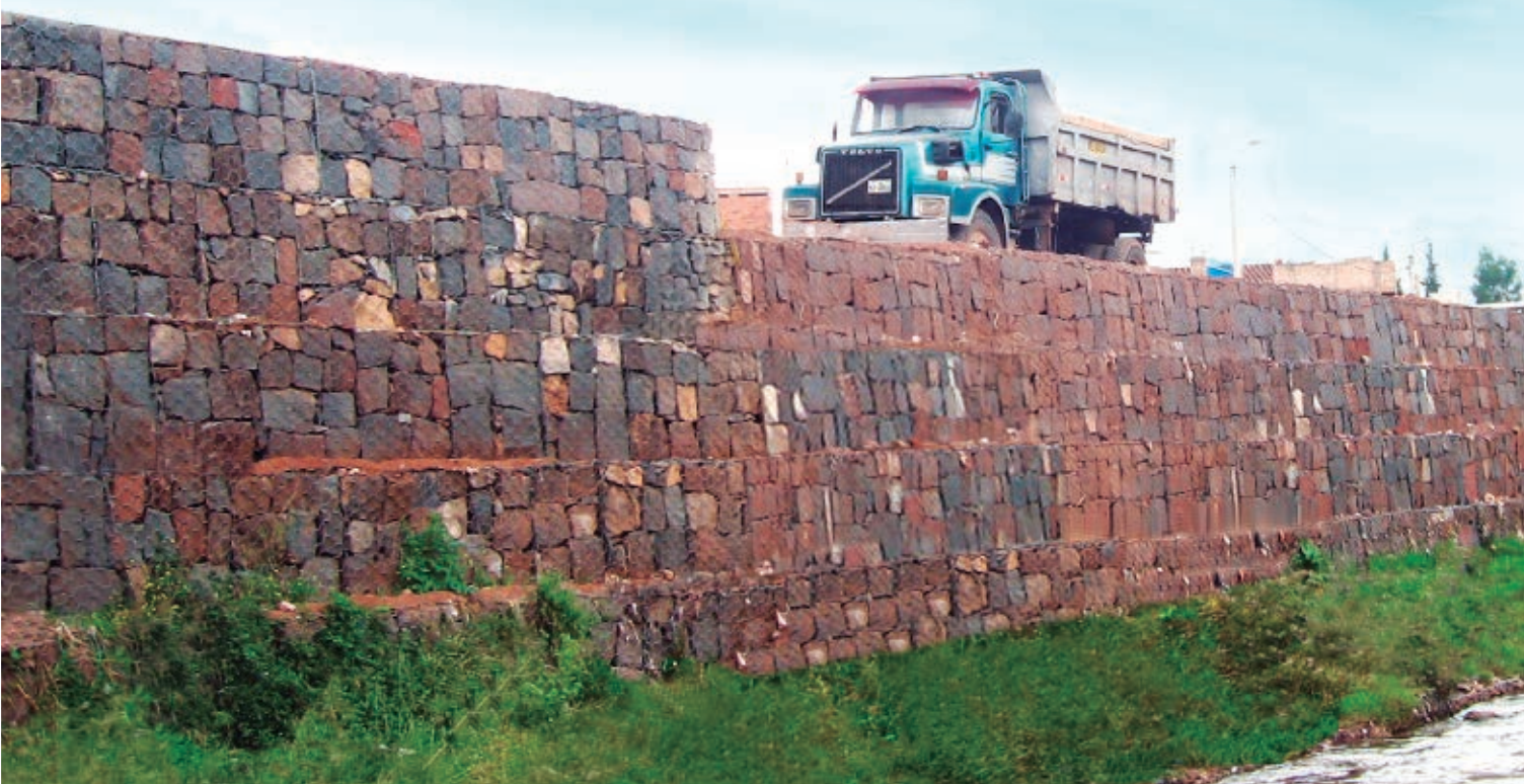
Gavi3n de suelo reforzado como muro de contenci3n.
