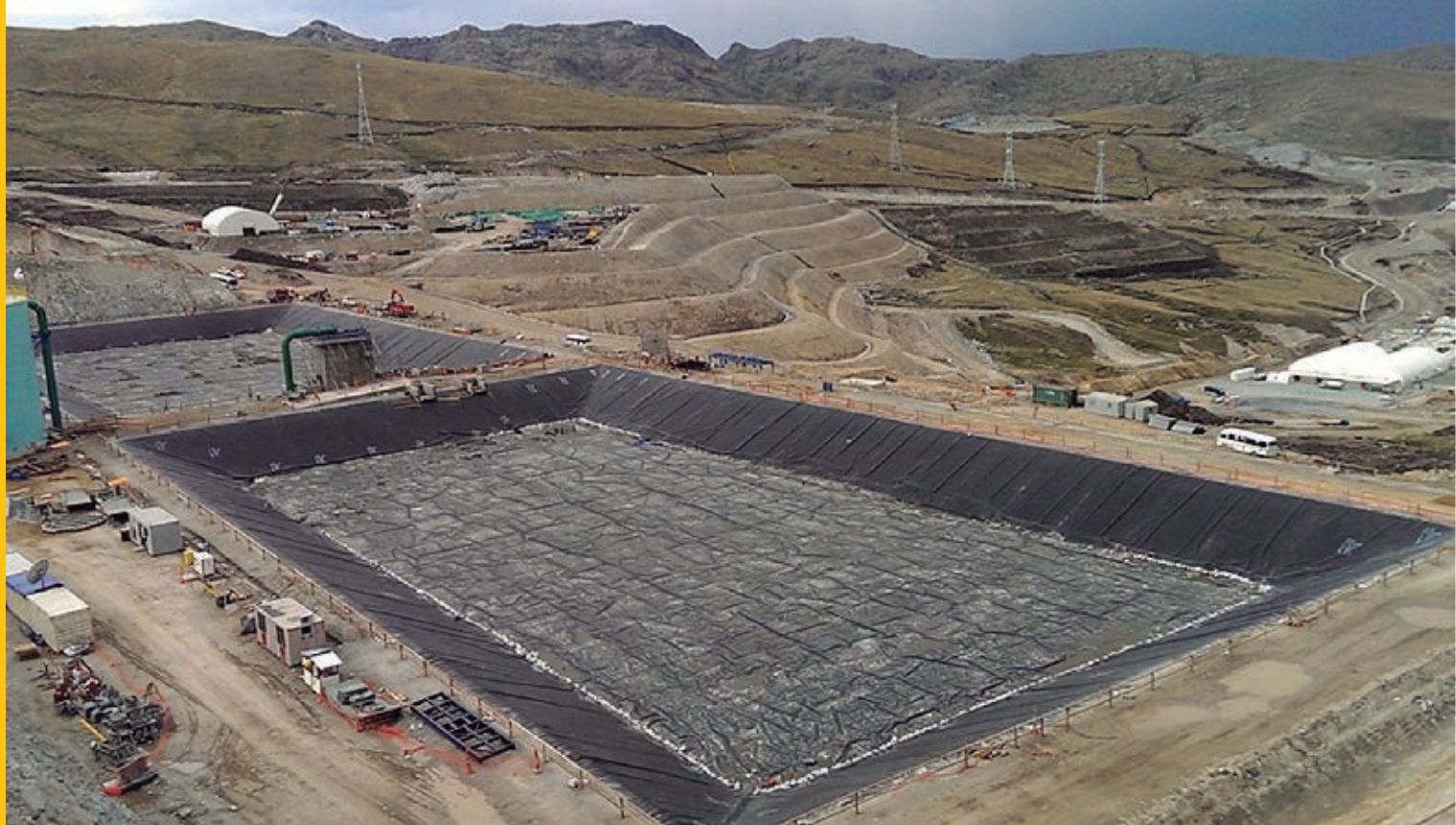
Depósito de residuos.
