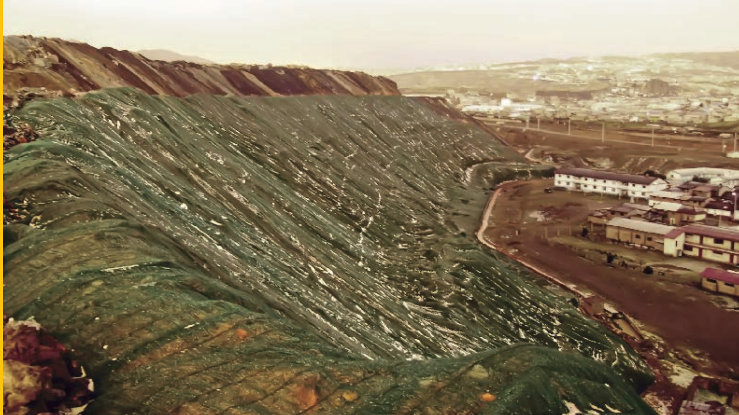
Protección superficial de talud con manto permanente.
