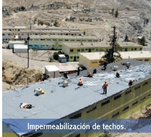
Control de calidad de geomembrana.
