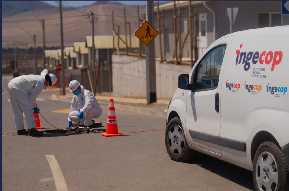
Nuestro proceso comienza con la meticulosa preparación del equipo: conectamos la cámara robotizada a su sistema CCTV mediante un cable eléctrico robusto, asegurando los enganches de seguridad para una operación sin interrupciones. Controlamos a distancia el robot con un transmisor de imagen portátil, lo que nos permite navegar con precisión por las tuberías.
