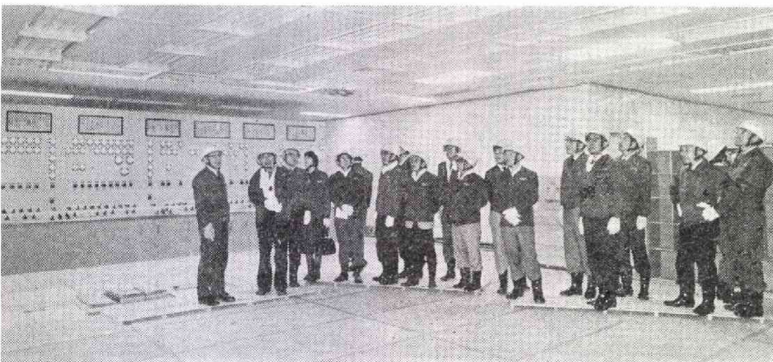
← 一号、二号のコントロールルームになる広い部屋。
