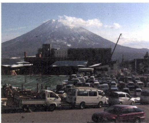
羊蹄山が雪を被っても 今冬の完成を目指して進む コンドミニアム建設工事
