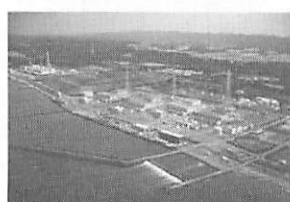
柏崎刈羽原子力発電所(新潟県)
