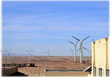
日本の円借款による支援で完成したエジプト・ザファーラーナ風力発電所
