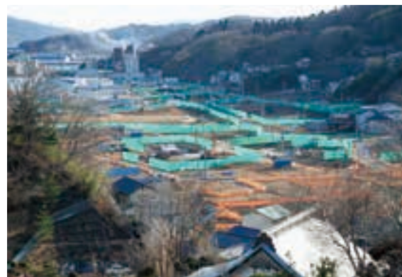
上・被災直後の鎌ヶ崎地区(市役所提供)と、下・土地区画整理事業導入後の現在(岩手日報社提供)。住宅再建に向けて急ピッチで造成工事が進む
