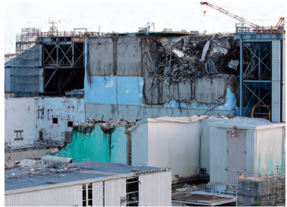
3号機は建屋上部のがれきを撤去、17年度中には燃料取り出しのアプローチを始める予定
