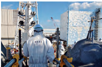
建屋近くの高台でバスを下車。左はがれき撤去に向けてカバー解体を進める1号機。右は水素爆発を避け、建屋が残った2号機
