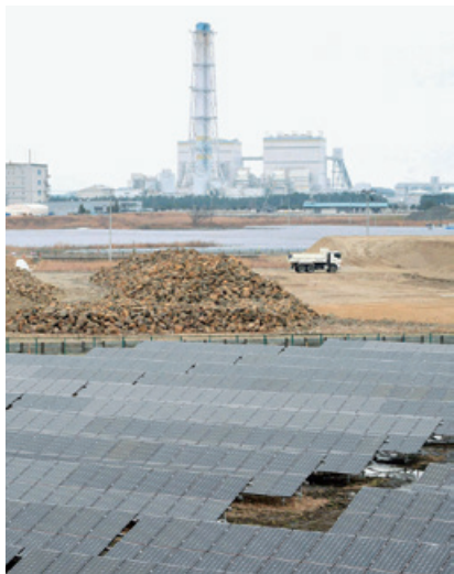
上・押し寄せた津波で被災家屋のがれきが田んぼ一面を埋め尽くした。後方は新地発電所＝2011年3月12日、相馬市原釜 下・太陽光パネルで敷き詰められた現在＝2016年2月20日（福島民友新聞社提供）
