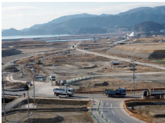
かさ上げ工事が進む陸前高田市の中心部。海側では防潮堤工事も続く。下和野災害公営住宅の屋上から撮影
