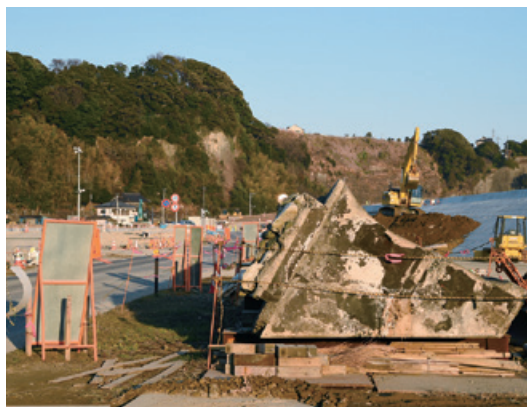
上・津波を受け大破した福島県いわき市岩間町の防波堤。道路付近まで流された＝2011年3月12日 下・復旧工事が進む同町の海岸線付近。今も壊れた防波堤が残る＝2016年2月4日（福島民報社提供）
