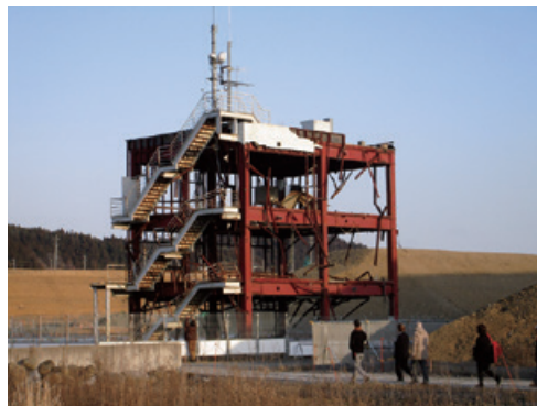
かさ上げの盛り土に囲まれた震災の記憶 南三陸町防災対策庁舎
