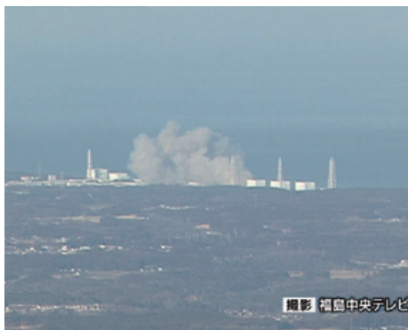
福島中央テレビの監視カメラが捉えた第一原発 1号機の水素爆発＝2011年3月12日（同社提供）
