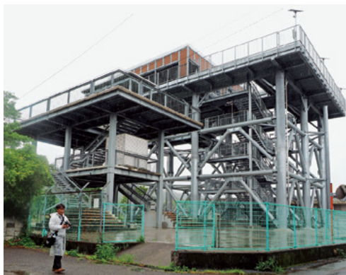
黒潮町万行地区津波避難タワー 左手前の踊り場のように見える部分は、新想定以前に作られた。高さが足りないことがわかり、新タワーを併設した
