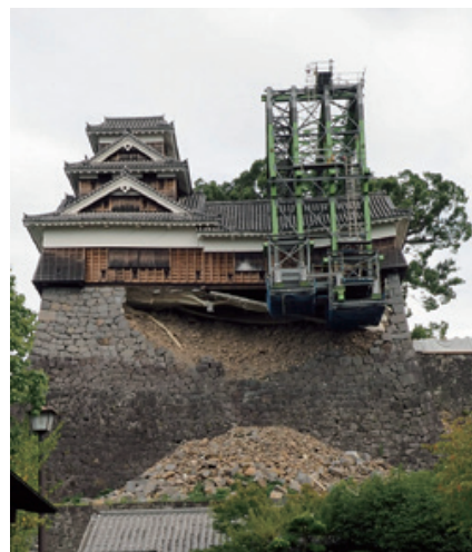
熊本城「飯田丸五階櫓」は右隅の「一本足」が辛うじて支えていた。倒壊防止の補強工事は7月末に完成(10.4)
