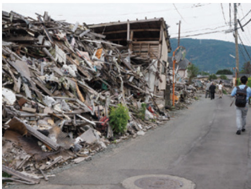
家屋の損壊が激しかった益城町中心部。解体作業の遅れが課題となっている(10.3)
