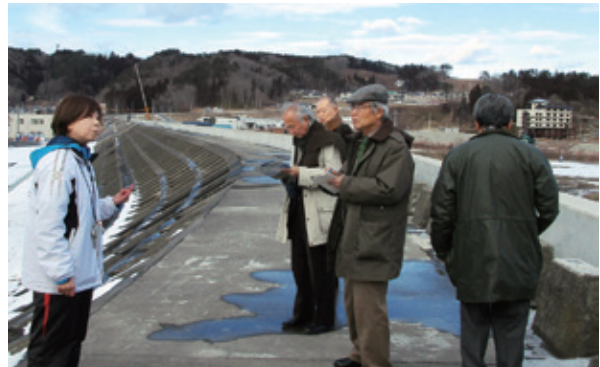
田老の防潮堤の上で。崩壊をまぬがれた部分に高さ70cmの追加工事が行われた。右奥は震災遺構第1号の「たろう観光ホテル」、山を切り崩した高台には復興住宅の建設が進む(中央奥)
