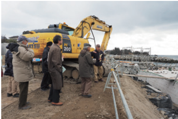
気仙沼からフェリーで大島へ。島内防潮堤の工事現場を視察
